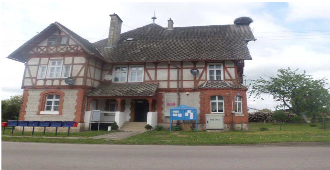
Budynek filii bibliotecznej w Podwilczu
